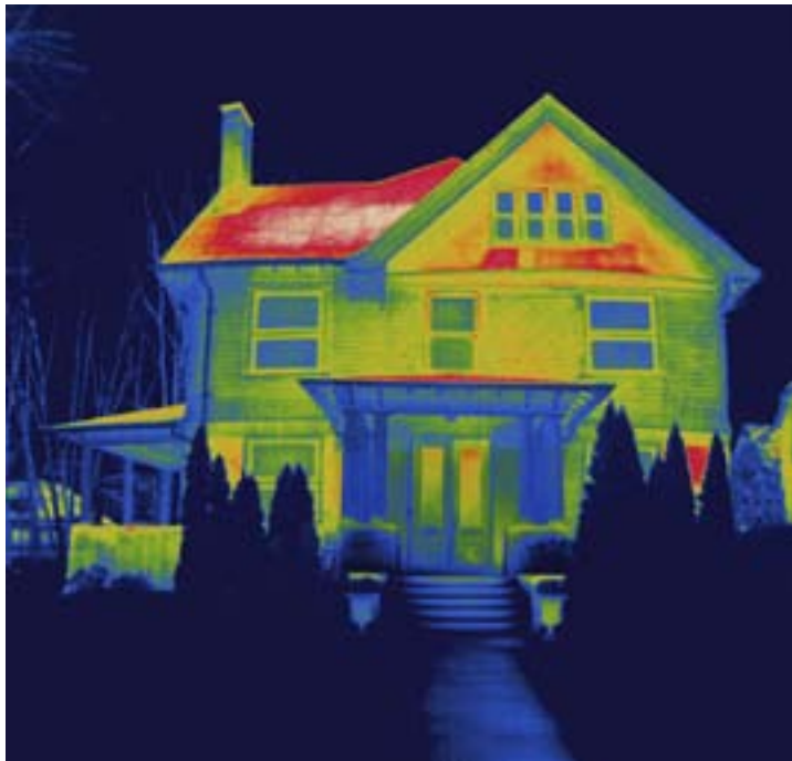
Топлинните загуби на къща в Ню Хейвън, САЩ.
