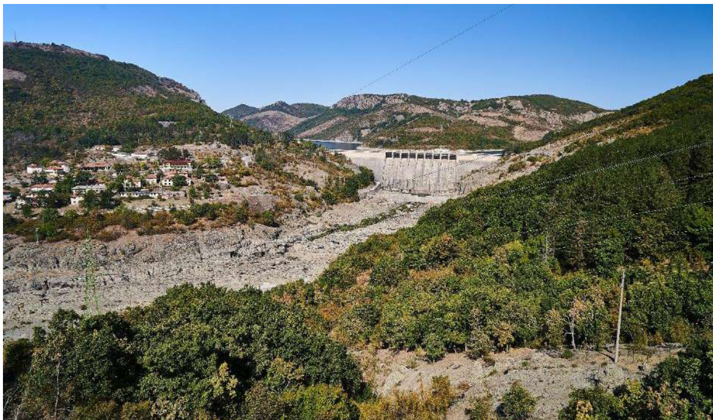
Фиг. 1.13 Стената на яз. Студен кладенец, изградена в долината на р. Арда.
