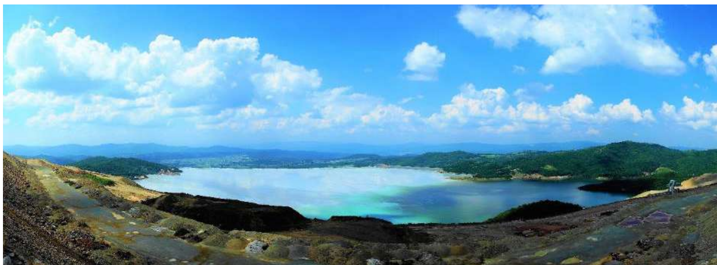
Фиг. 2.20 Долината на р. Люляковица в Средна гора, превърната в насипище за минни отпадъци и хвостохранилище с обща площ ок. 600 ха.
