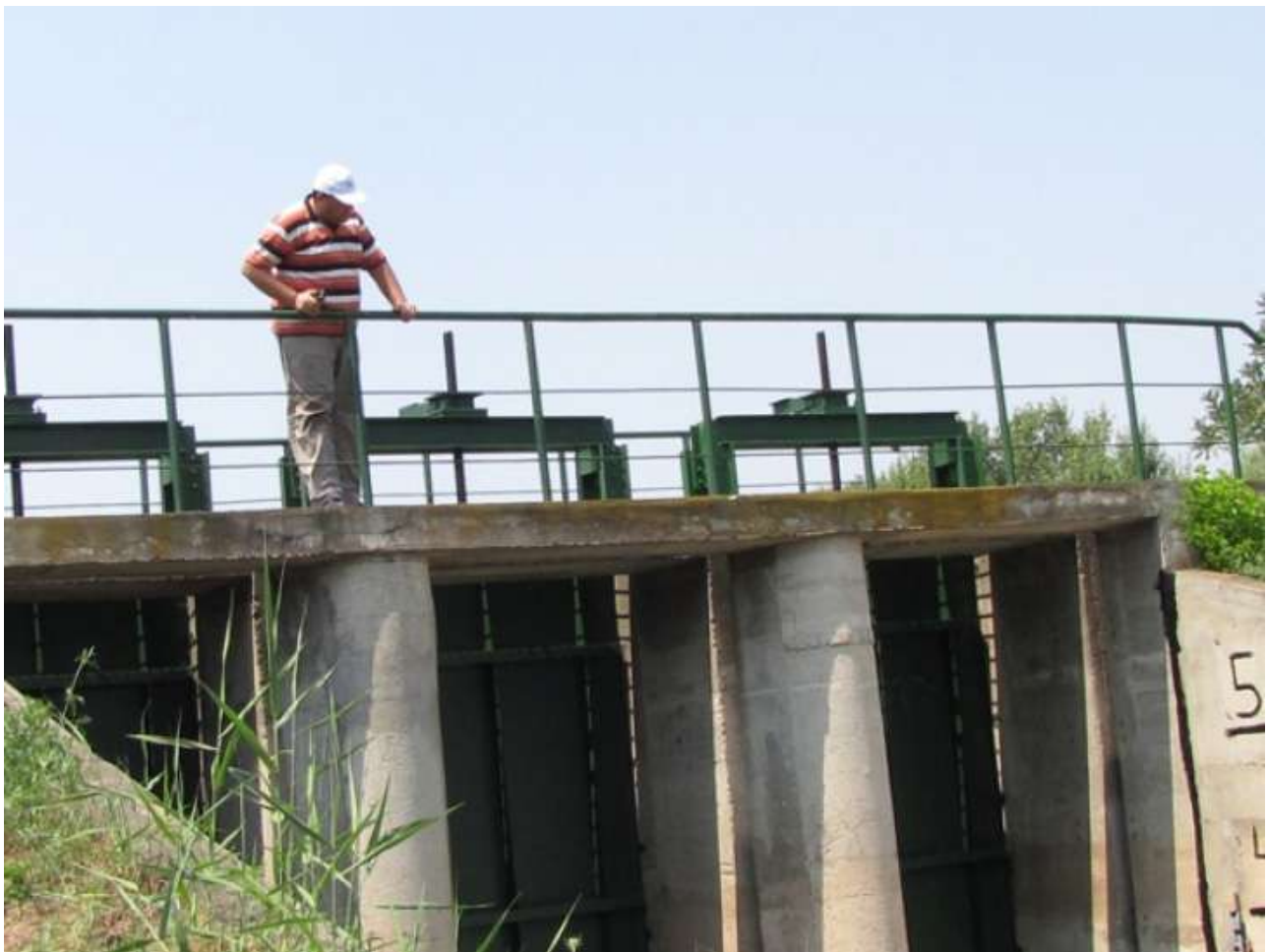
Фиг. 4.13 Шлюзовете на ез. Сребърна позволяват управление на водното ниво, но също и намаляват риска от наводнение за населението и обработваемите земи. (сн. https://srebarnalake.com )
