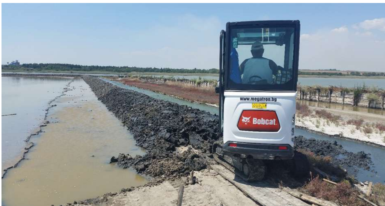
Фиг.4.7 Поддържане на местообитание 1310 Salicornia и други едногодишни видове, колонизиращи пясъчни и тинести терени чрез насипване на минидиги с помощта на малък багер в Атанасовско езеро (сн. ©Деян Томов).
